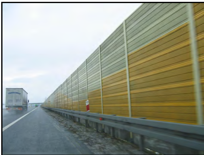
Fot. 2. Przykład typowego zastosowania ekranu akustycznego na autostradzie A2
